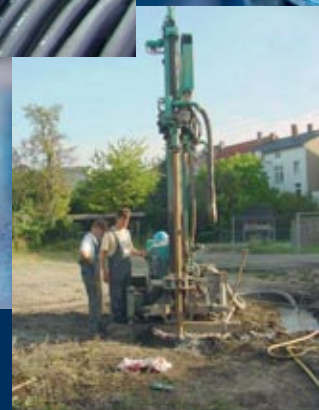
Es wurden insgesamt 20 Erdwärmesonden vertikal verlegt. Die Bohrtiefe betrug jeweils 100 Meter.
